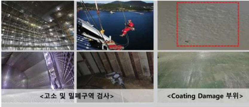
<죽장 설치 및 고소 작업자 투입 (좌), 죽장 설치로 인한 도막 데미지 구역 (우)>
